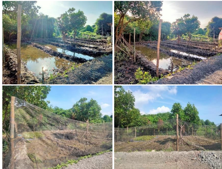
Gambar 9. Dokumentasi Pemasangan Pagar
