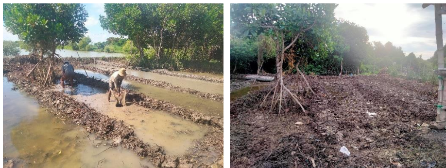
Gambar 8. Pembuatan Jalan Poros Tengah
