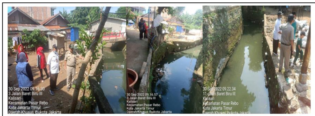
Gambar 1. Situasi Kalisari Kec. Pasar Rebo
