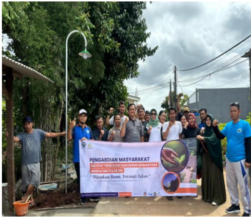
Gambar 4. Pemasangan tiang dan lampu PJU
