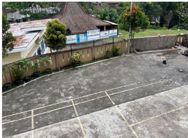
Gambar 1. Kondisi Area Sekolah
