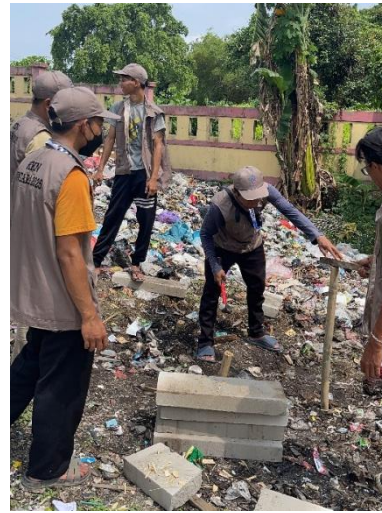
Gambar 13. Pemasangan cerucuk
