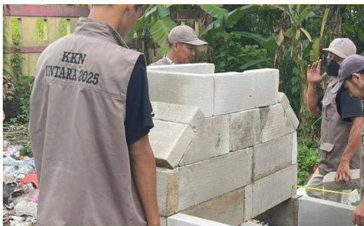
Gambar 16. Pemasangan Hebel
