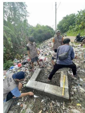
Gambar 15. Pembuatan lantai kerja
