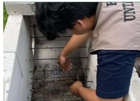
Gambar 17. Pemasangan Besi D8
