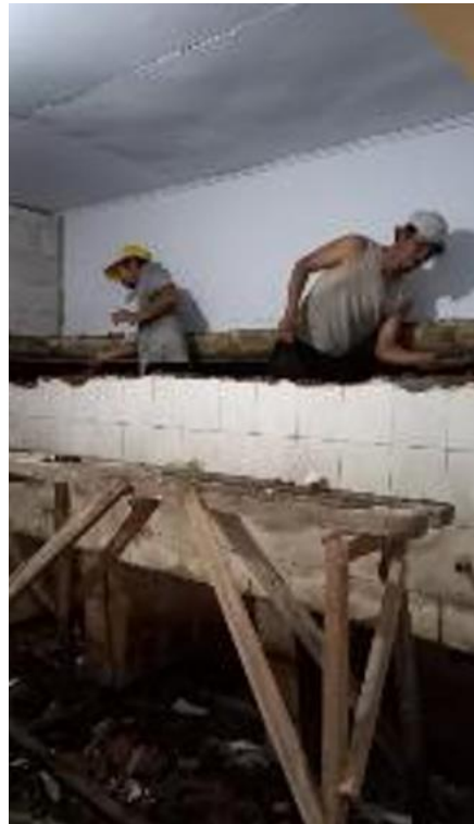
Gambar 3. Proses Monitoring Pelaksanaan Konstruksi
