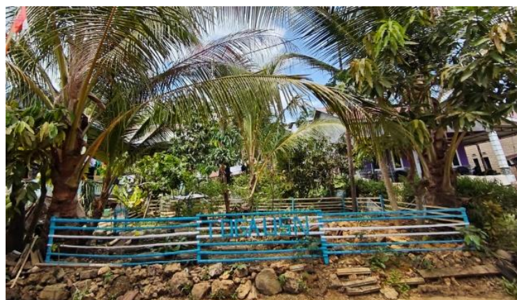
Gambar 5. Pemasangan dan Pengecatan Pagar TOGA
